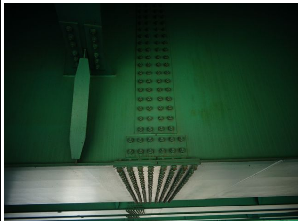
거더외부 스플라이스 전경
